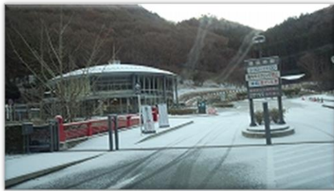
霊園管理事務所付近
